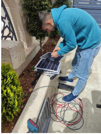
Figure 3-4- توصيل الألواح على التوالي للاختبار
